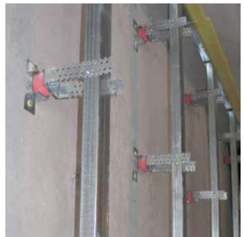
Каркас гипсокартонной облицовки, смонтированной с помощью креплений Vibrofix™
