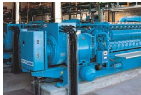
Виброизоляция генератора
